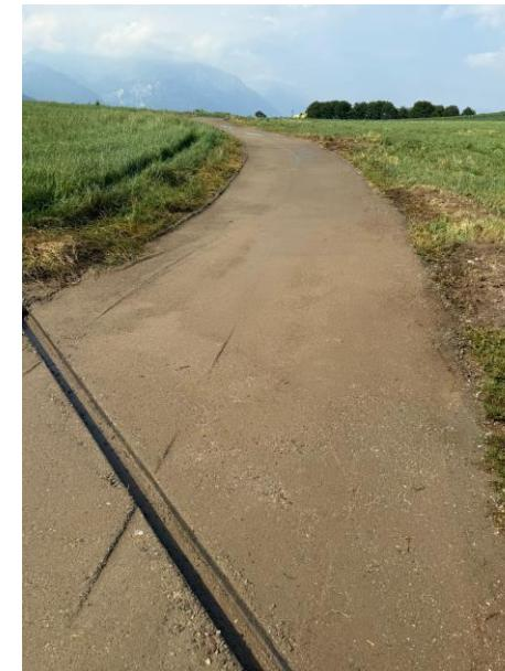
Stabilizzazione del fondo dei percorsi tramite l'utilizzo di legante naturale steso a spruzzo in zona Dro/Drena e Comano. Posa di ulteriori canalette per migliorare il deflusso dell'acqua ed evitare l'erosione del sedime.
